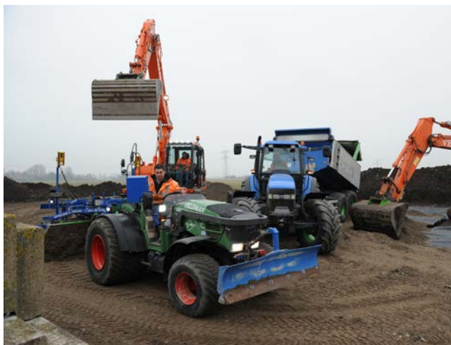
Naast het kilveren voert Veldman ook ander grondverzetwerk uit. Soms gaan het grondverzet en het kilveren samen, zoals hier een klus die op de laser wordt afgewerkt.
